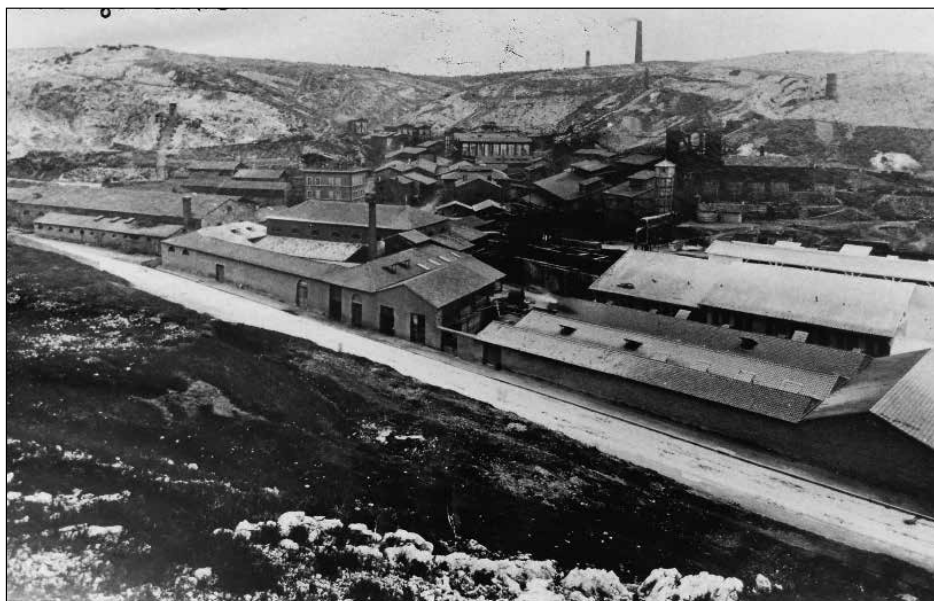
Usine Duclos située le long de la route d'Aix (ex RN 8).
